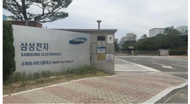
구미 삼성전자 제2공장
